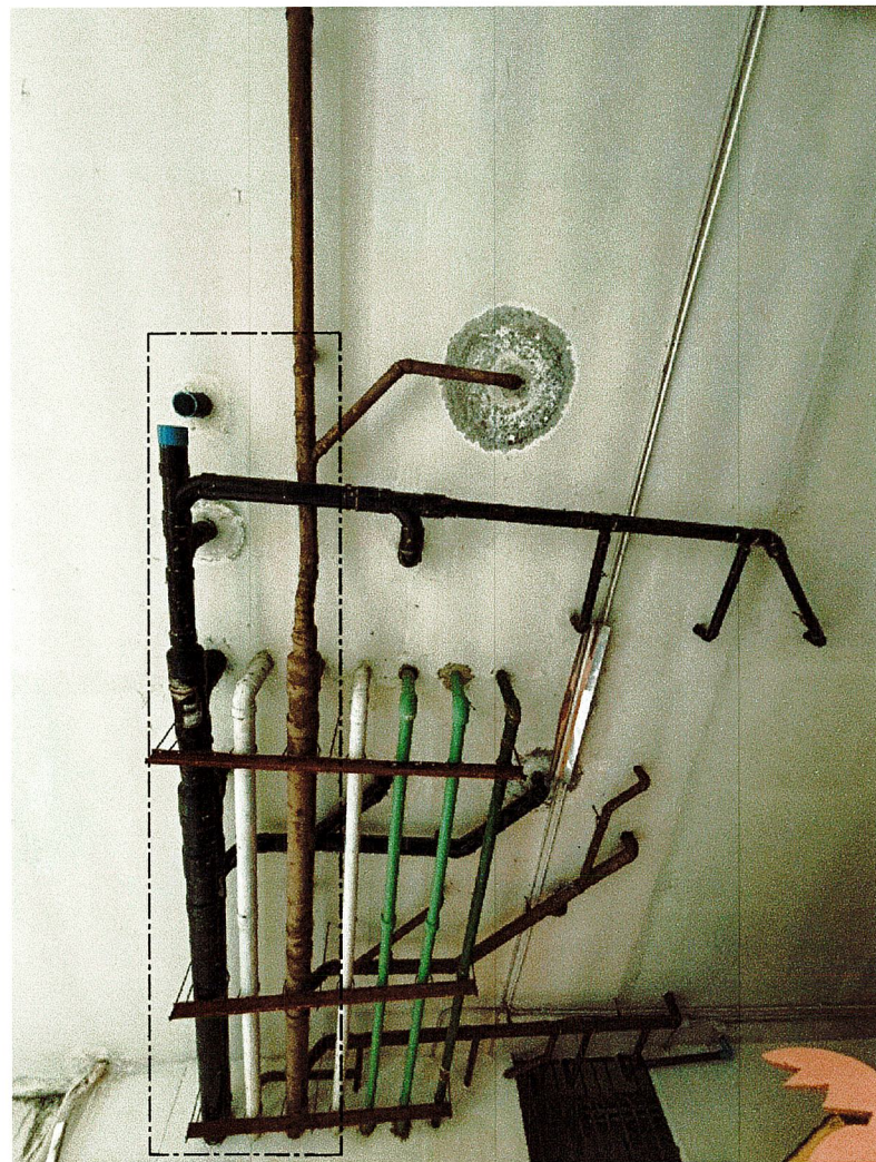
รายการท่อเปลี่ยนใหม่
