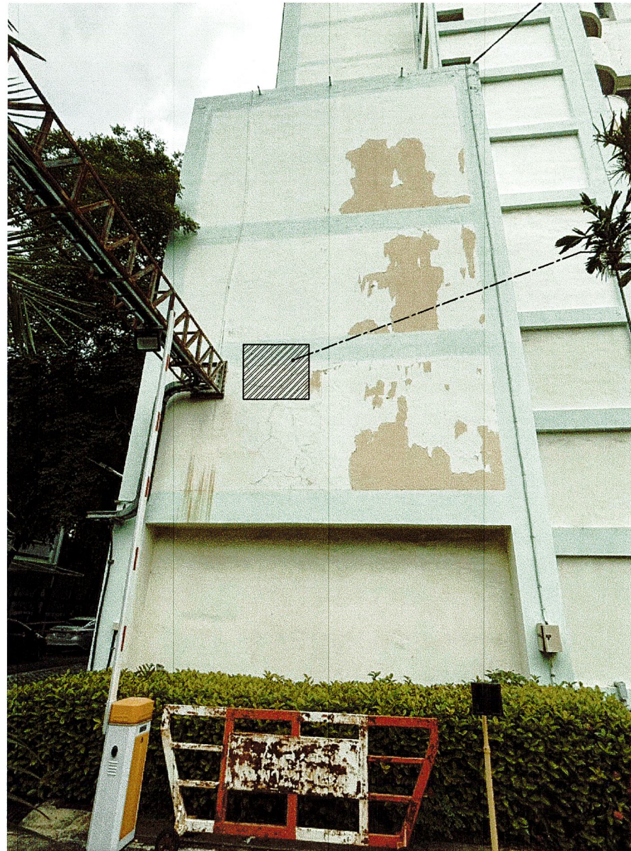
ตำแหน่งโครงเหล็กห้อง PUMP ROOM เชื่อมอาคาร 15
