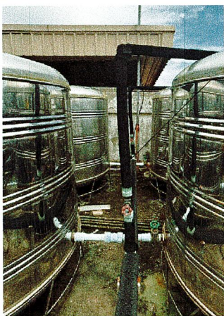
CWด1"แนวตั้งจากหลังประตุน้ำ(ของเดิม)เข้าถึงน้ำดี เปลี่ยนใหม่ ชนิด PPR พร้อมฉนวนหุ้ม
